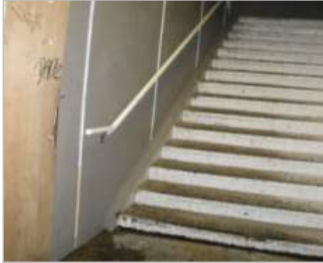
Escaleras de Estacionamiento
